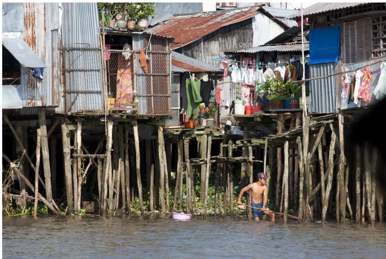
Figura 2: Case sul delta del Mekong. Queste case tradizionali rappresentano un caso di intelligenza progettuale. Le palafitte non "lottano" contro i cambiamenti del fiume, ma li assecondano, assicurando la resilienza del sistema indipendentemente dalla portata delle piene (CC BY 2.0 Katina Rogers).
